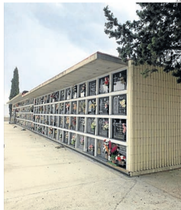
Se han reparado las humedades de un pabellón de nichos.
